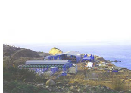
VISITE D'INSPECTION DE LA SDEM DE TIGHREMT
